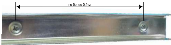
Рис. 56. Пример крепления кабель-канала металлического огнестойкого.
