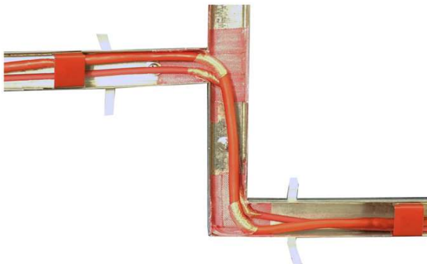
Рис. 58. Пример укладки кабелей в ККМО
