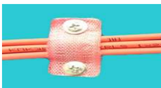
Рис. 8. Установка дюбель–хомута (Вариант 2).
